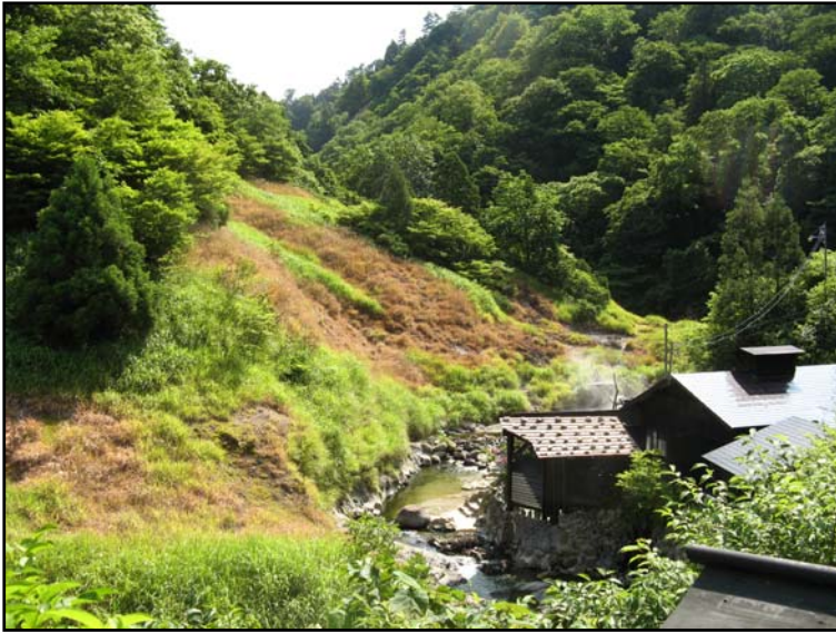
図 15. 大湯温泉阿部旅館の沢向かい斜面で草枯れが広がっています。この枯れは地震後に発生し、拡大したとのことです。これは地震動で地層中のき裂が開いて自然噴気の噴出範囲が拡大し、地温が上昇して枯死が発生したと考えられます。2008 年 7 月 2 日撮影。
