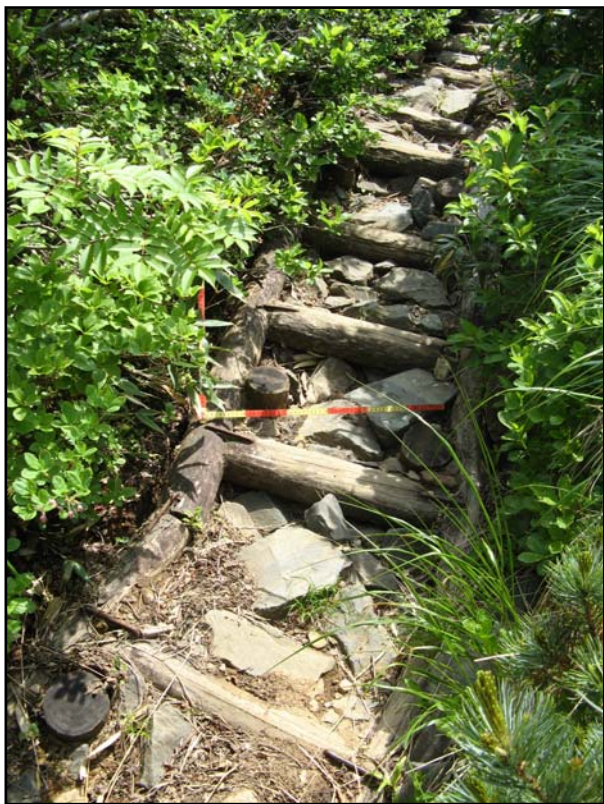
図 11. 産沼ルートの登山道にあらわれた短縮変形です。登山道の梯子状の木柵は短縮によってゆがみ、ジグザグに変形しています。スケール手前の木柵と割り石は浮き上がっていないのに対して、後方の木柵は 10cm ほど浮き上がり、割り石も浮き上がっていることから、地盤が隆起しているようにみえます。スケールは 10cm 間隔で赤く塗色してあります。2008 年 7 月 2 日撮影。
